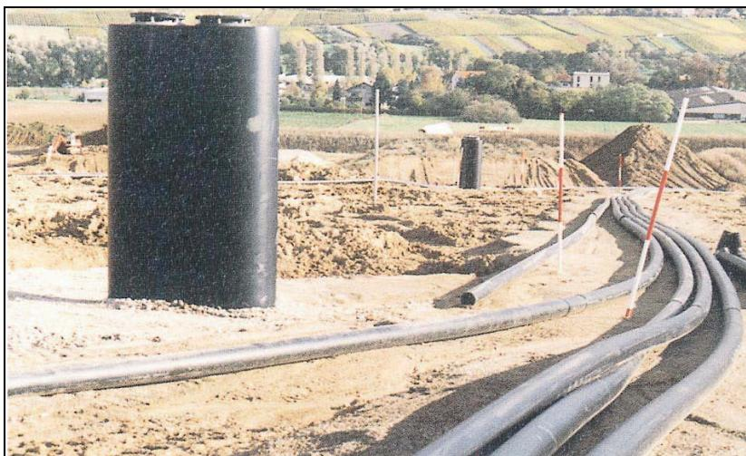
Слика 4.16. Пример система за сакупљање гаса
